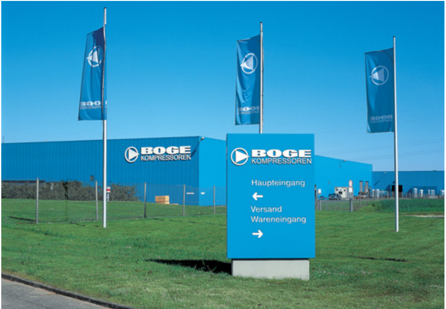
Werk Bielefeld: Modernste Produktionsanlagen garantieren höchste Fertigungsqualität.
